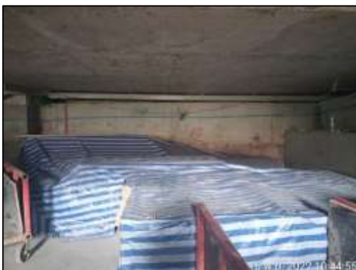
ภาพที่ 38 ผ้าใบปิดคลุมกองวัสดุก่อสร้าง
